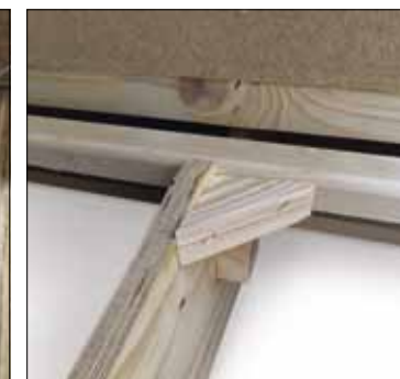
Rinforzi angolari Angle reinforcements
