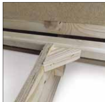
Rinforzi angolari Angle reinforcements
